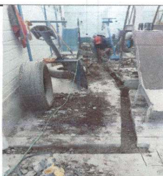
Foto 5: Colocación de tubería para drenajes de agua pluvial
