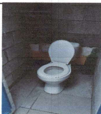
Foto 3: Colocación de taza sanitaria
