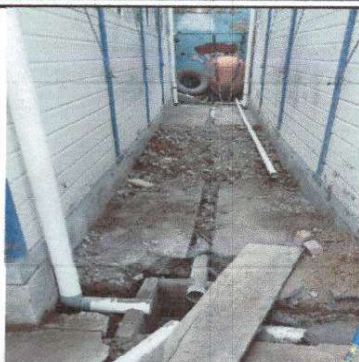
Foto 6: Colocación de bajadas de agua
