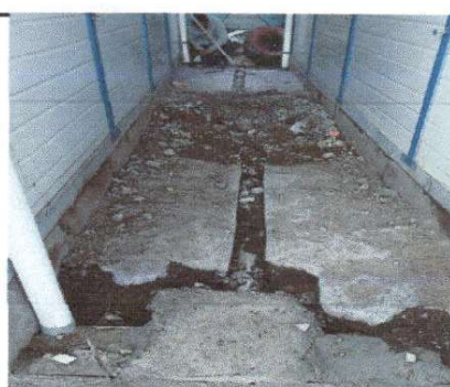
Foto: Colocación de tubería y piso
