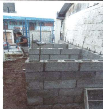
Foto 8: Levantado de pared de servicios sanitarios
