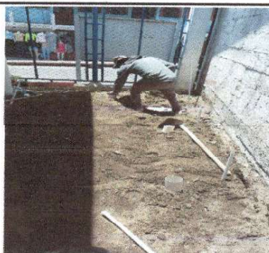
Foto 10: Preparación de terreno para ubicar servicios sanitarios
