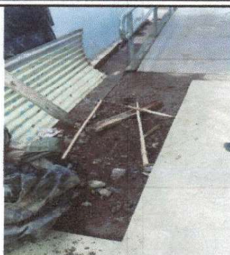
Foto 1: Construcción torta de cemento
