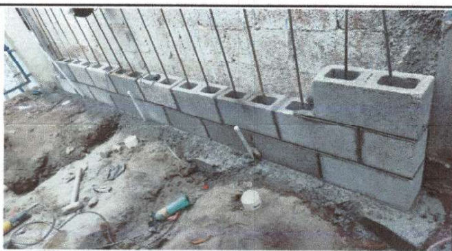
Foto 9: Levantado de muro perimetral
