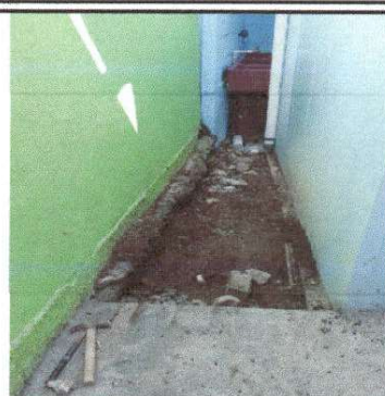
Foto 2: Construcción torta de cemento
